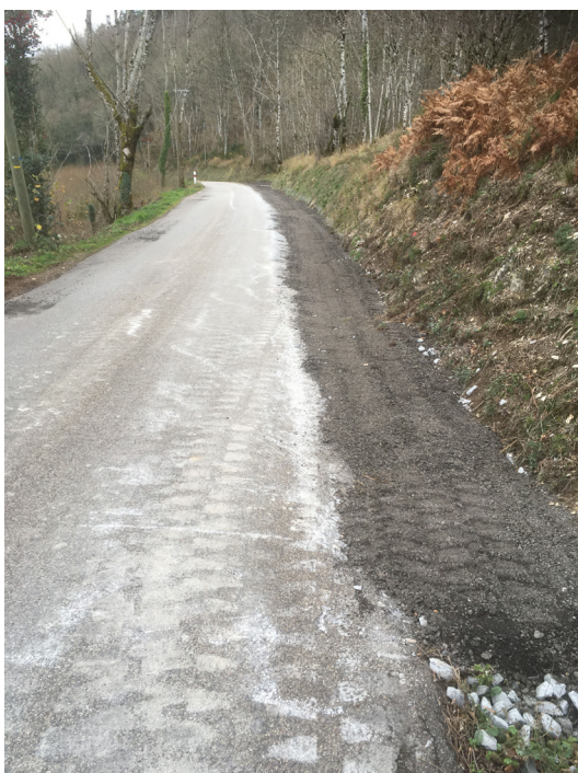
Travaux d'élargissement de voirie à Montaigut
