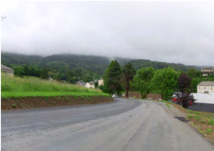
Elargissement voirie face Granisse
