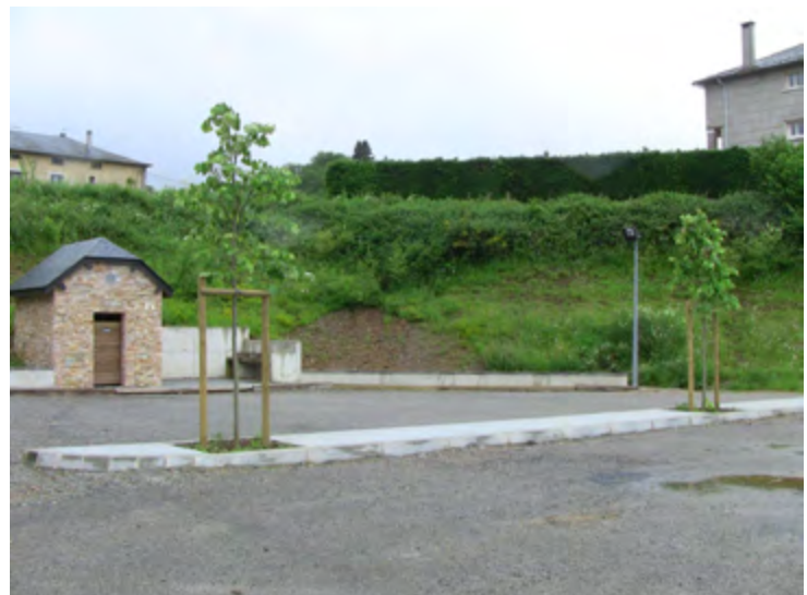
Aménagement boulodrome extérieur au stade de la Balmette
