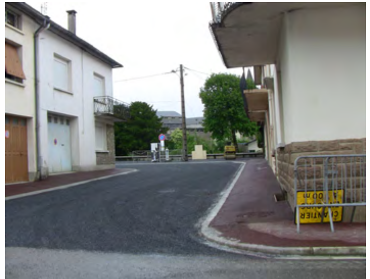
Voirie et trottoirs rue G. Clémenceau
