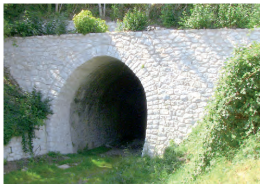
Coup de fraîcheur pour le tunnel (sablage et jointage)
