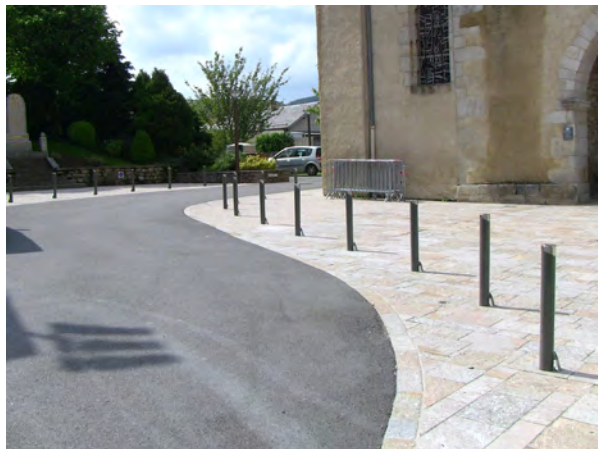
Mise en place de plots Place de l'Eglise
