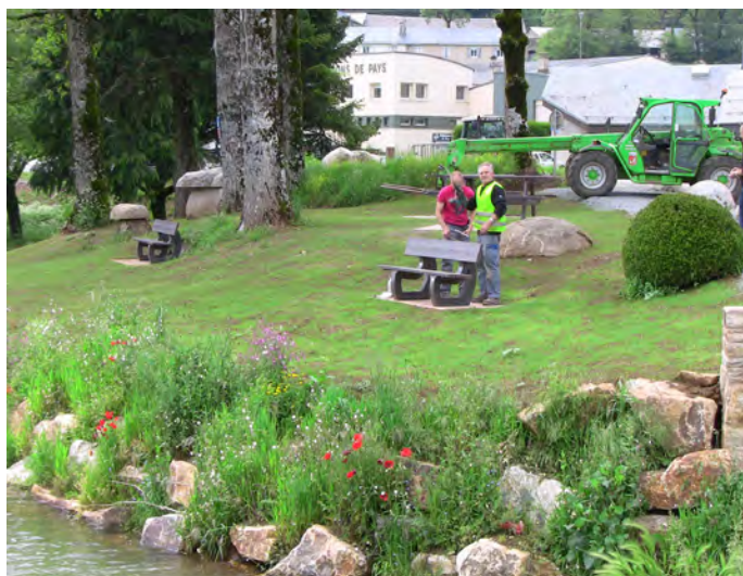
A Granisse, installation de bancs, de tables et d'un pont
