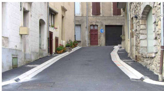
Au centre ville, remise à neuf de la rue Malroux (bordures et enrobé à chaud).
