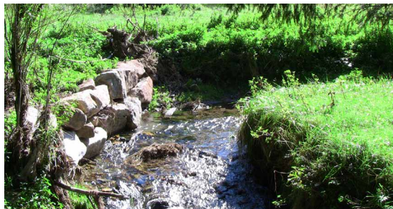
Enrochement de berges à Farayruc
